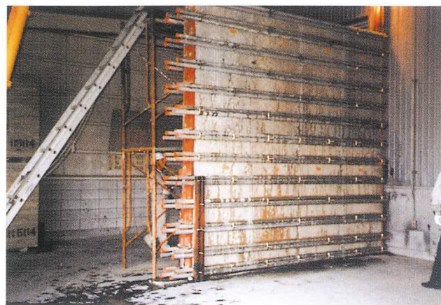
PMW使用 壁型枠コンクリート打設試験
