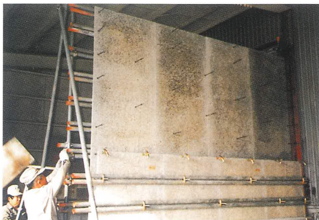
PPW使用 壁型枠コンクリート打設試験
