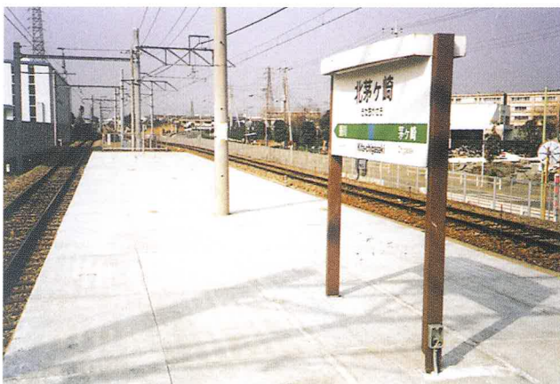
PMW使用 北茅ヶ崎駅ホーム 浅岡建設(株)
